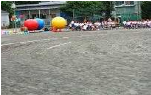
北秋津小学校の校庭 雨水対策工事が始まりました 来年度の運動会前には完成します
